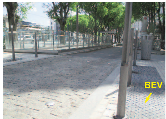
Traversée suggérée par changement de matériaux équipée de BEV, mais sans marquage de passages pour piétons
